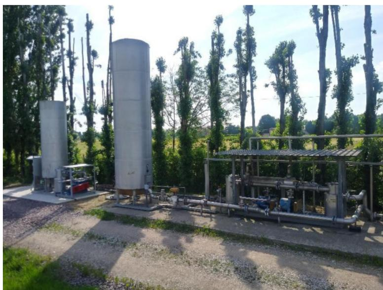
Fig 10-10 A sinistra la torcia dell'ampliamento
