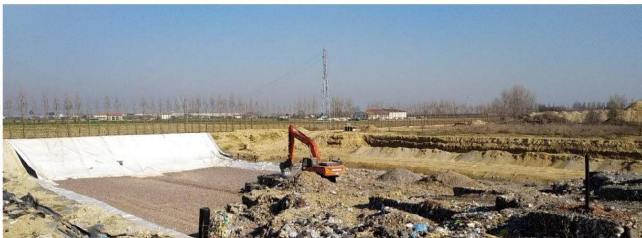
Fig. 9-2 Copertura del fronte non attivo con terriccio e posizionamento dei rifiuti in balle affiancate nel fronte attivo
