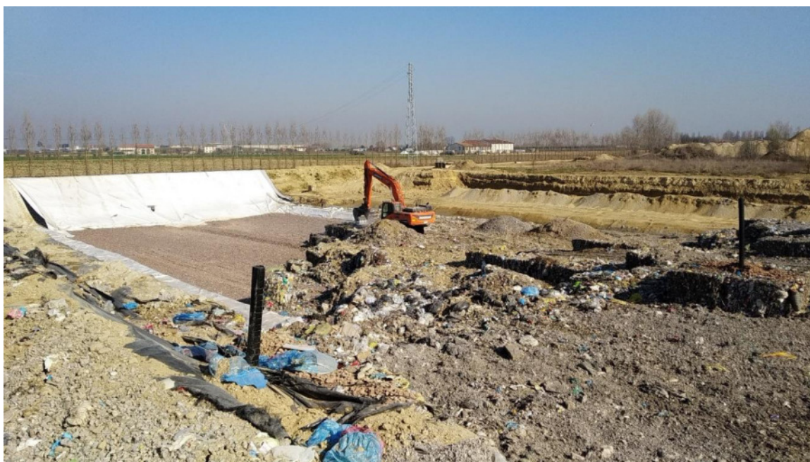
Fig. 9-3 Copertura del fronte non attivo con terriccio e posizionamento dei rifiuti in balle affiancate nel fronte attivo
